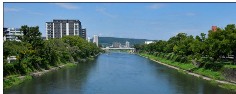
▲ Une section où le chenal du fleuve a été élargi 河道の拡幅がなされた区間
